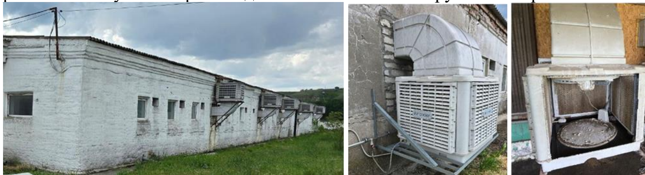
Рис. 2. Додаткова система охолодження в секціях другої дослідної групи Джерело: фото авторів
